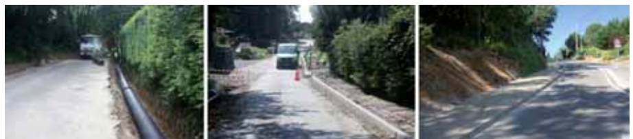
Les travaux ont permis la création d'un cheminement piétonnier et des ralentisseurs. Ainsi, depuis le haut de la côte de Boy jusqu'au village, la continuité piétonne sécurisée sera assurée.
