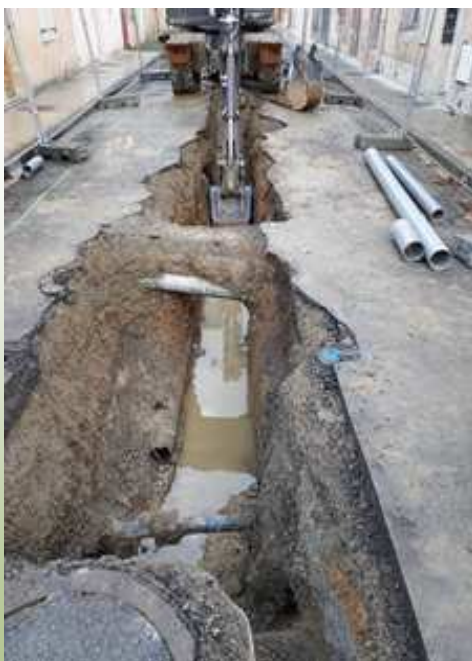
Travaux dans la rue du Sang
