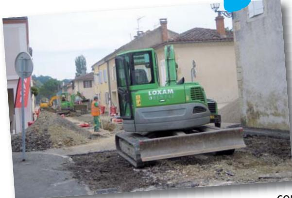
Outre le réseau d'eau potable et avant la réfection de la chaussée on a remplacé en totalité les collecteurs et les branchements Eaux Usées et corrigé quelques défauts du réseau pluvial.
